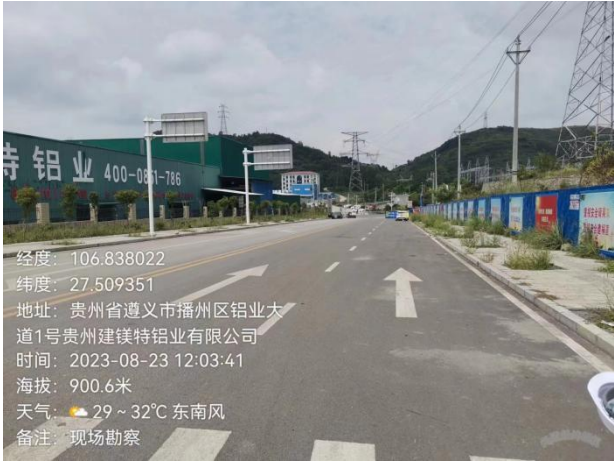
项目南侧园区道路
